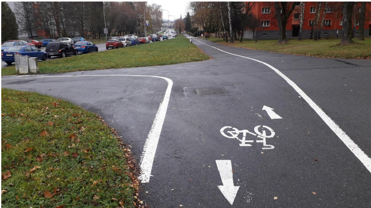
Obrázek 69 Stezka pro chodce a cyklisty bez dělicího varovného pásu pro nevidomé a slabozraké
